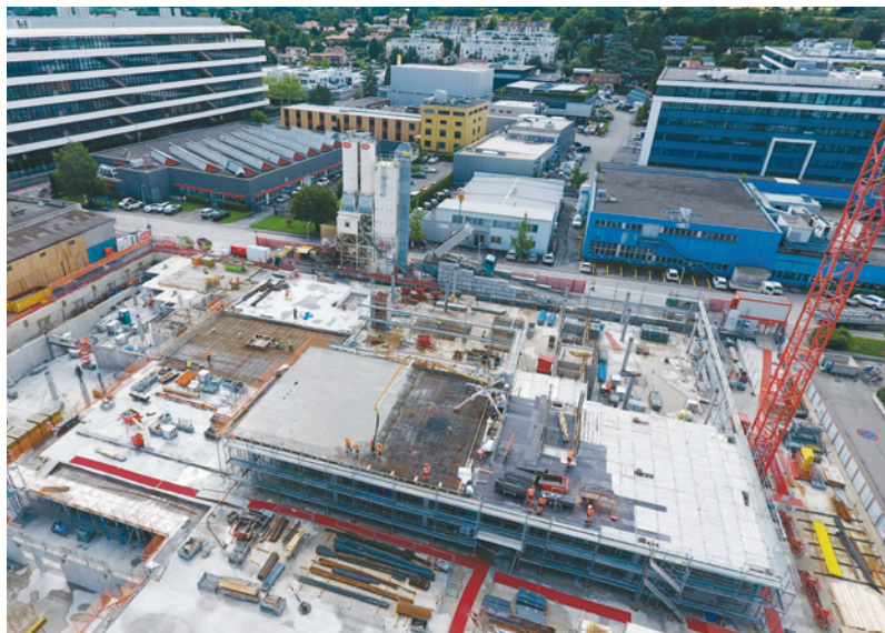
Die Baustelle des Projekts Spark in Plan-les-Quates.
